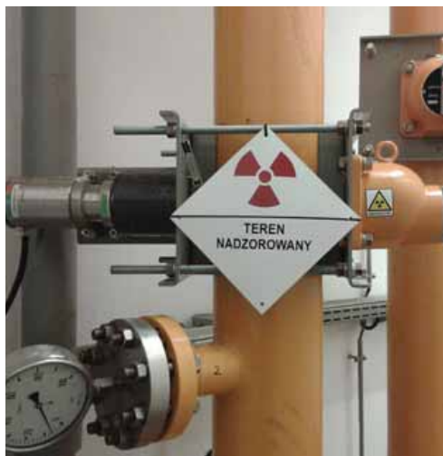
Rysunek 7 Zainstalowany izotopowy układ pomiarowy
