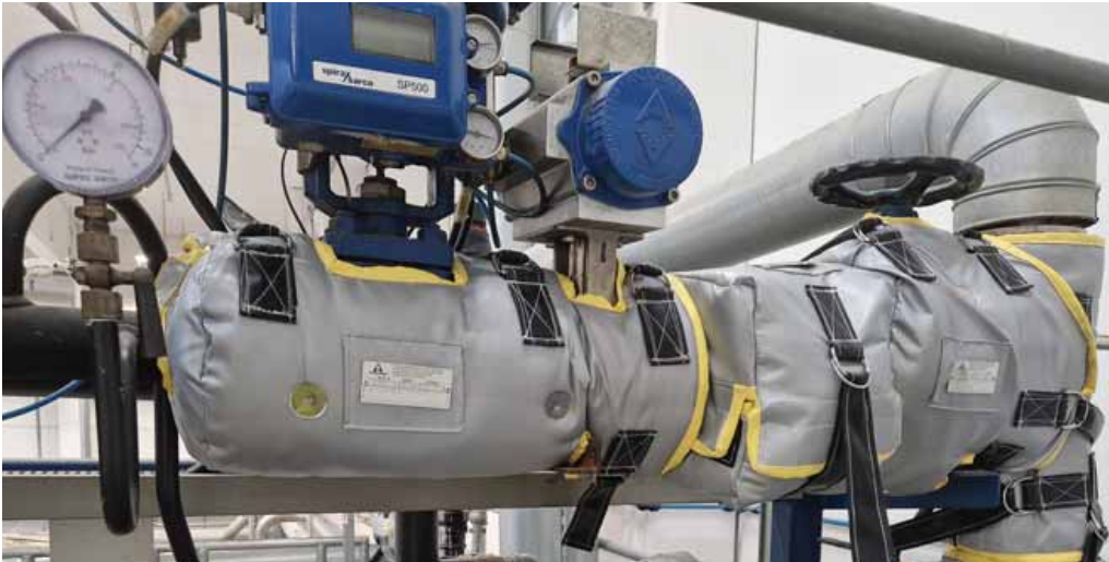
Rysunek 7 Systemy mocujące gwarantujące łatwość demontażu/montażu izolacji
