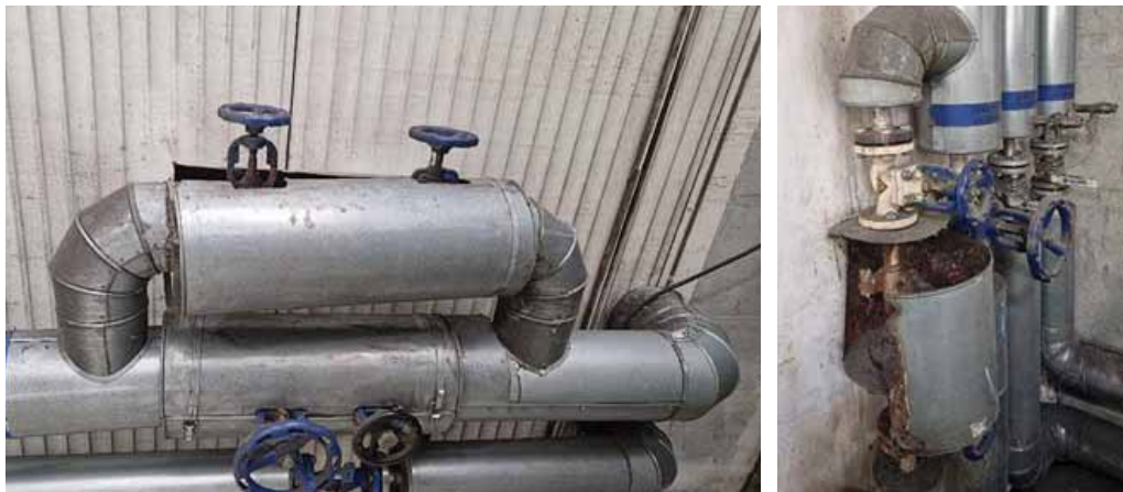
Rysunek 2 Izolowanie zaworów wełną mineralną w blaszanej ostonie
