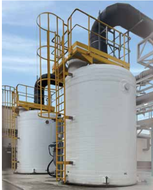
Rysunek 5 Dwie jednostki neutralizacji chloru o zdolności sorpcyjnej 1000 kg chloru każda
